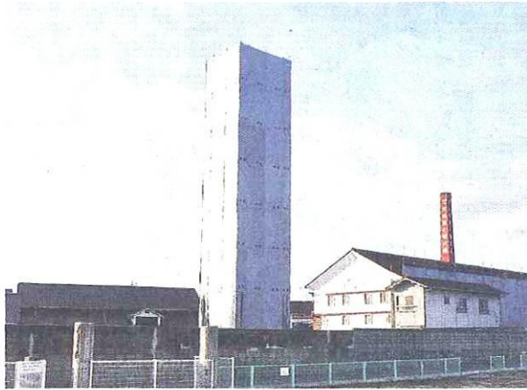
解体工事が始まった賀茂鶴酒造の吉富蔵
