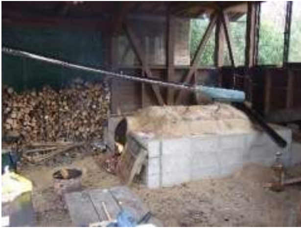
炭窯に新しい集煙・排煙装置を取り付けました
