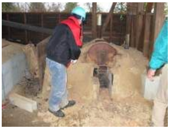
撤去作業中のドラム缶炭窯
