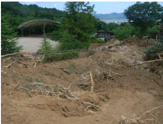
「ひだまりの庭」方面より「多目的広場」を望む
