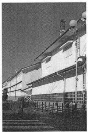
「山と水」環境機構の建設現場には、西条酒造組合と東広島市西条本町で
